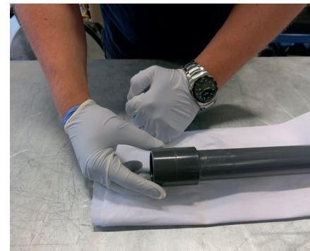
Låt torka. Torktid 1h/1bar vid 20°C för provtryckning med vatten. 24 h fullt driftstryck
